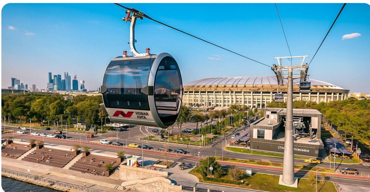
Протяженность канатной дороги от верхней станции «Воробьевы горы» до нижней станции «Лужники» — 720 м, перепад высот — 60 м, высота канатов над уровнем воды — 35 м. Путь в одну сторону занимает 7,5 минуты. Помимо 33 стандартных, на канатной дороге есть две 4-местные кабинки VIP-класса с кожаными креслами. Летом в кабинках оборудуют специальные места для велосипедов и самокатов, зимой — для лыж.
